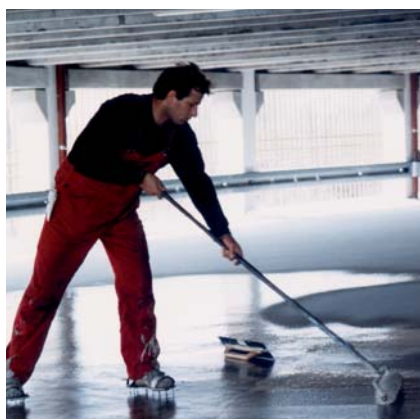
Nanoszenie maszynowe powłoki uszczelniającej (zasadniczo czynna powłoka ochronna dla nawierzchni).
