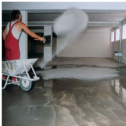
Ręczne nanoszenie powłoki uszczelniającej (zasadniczo czynna powłoka ochronna dla nawierzchni).
