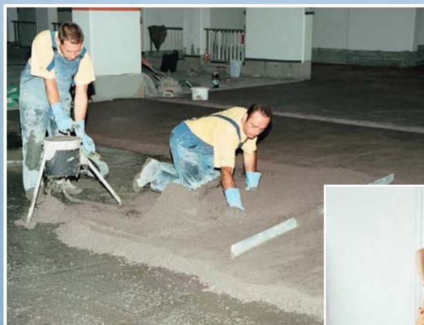
Wykonanie powierzchni jastrychu z PCI Novoment® Z1 lub Z3 w celu terminowego oddania obiektu do użytku.
